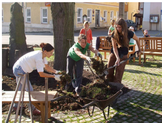
V letech 2013—2014 došlo na nadějkovském náměstí k realizaci navržených úprav a brigádnicky se částečně podařilo provést některé uvažované práce.
